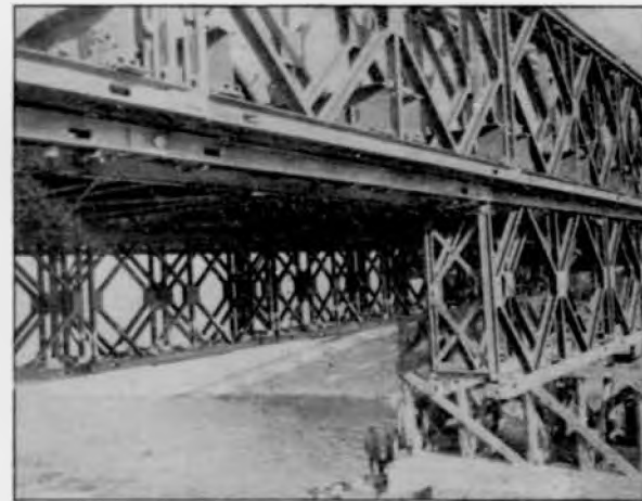
DER FIG. 2 UNSLUNG REINFORCING PANELS
